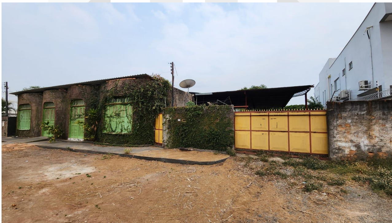
Vista do Imóvel Avaliando
